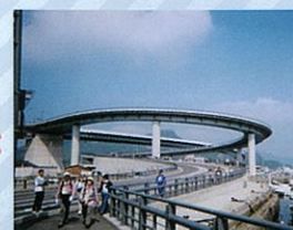
大橋を渡り下から見る ハイヤ大橋
